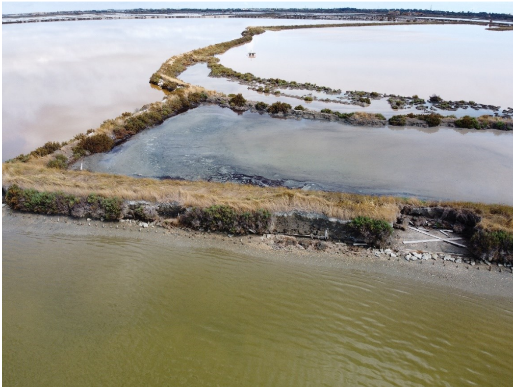
Figura 2 - Sezione 19, sulla destra, vista da ovest
