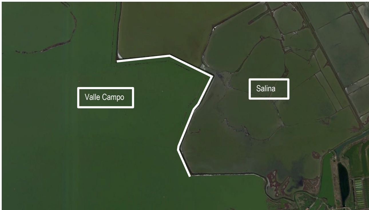
Figura 7 - Tratto di argine Lamenterio interessato dai lavori (indicato con linea bianca)
