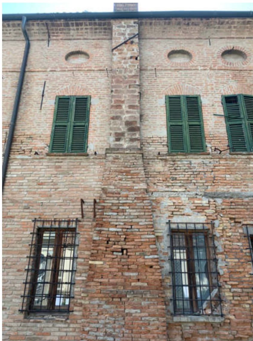
Canna fumaria prospetto ovest a destra del portone di ingresso posteriore
