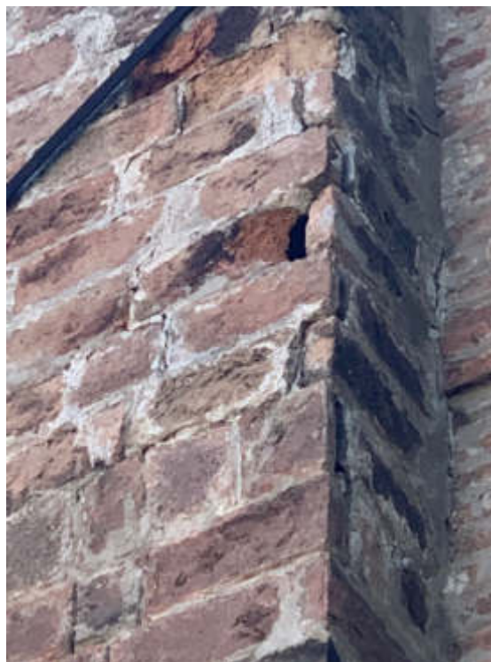
Particolare della canna fumaria nella parte alta con evidenza di crollo di porzione di laterizio
