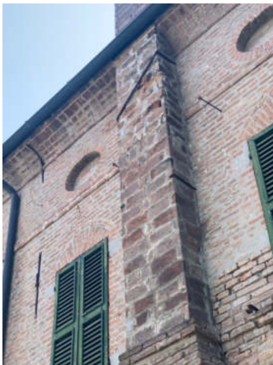
Particolare della canna fumaria nella parte alta con evidenza di crollo di porzione di laterizio
