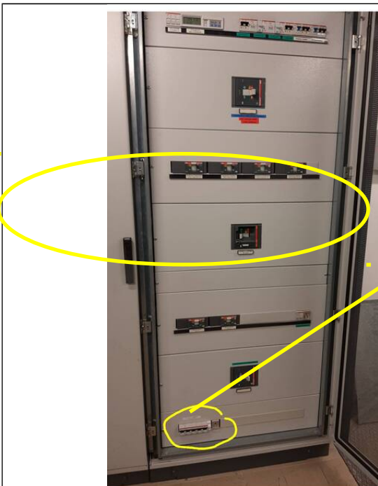
Q UPS al piano interrato 4xC125 + relè diff Linea diretta al Q PET
