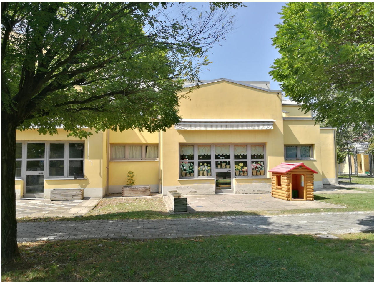
Fig. 5 – Vista esterna - Fronte su via Verdi
