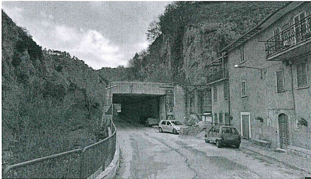
Comune di Posta – Sigillo – Galleria paramassi
