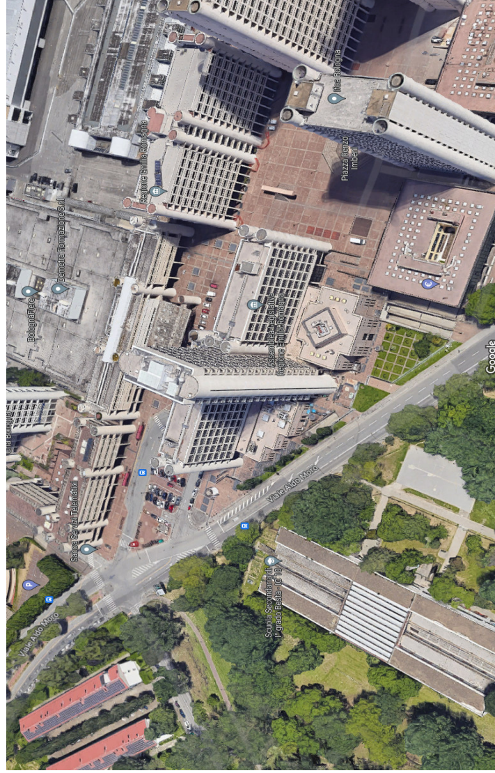
Figura 4 - Vista Sud dell'edificio
