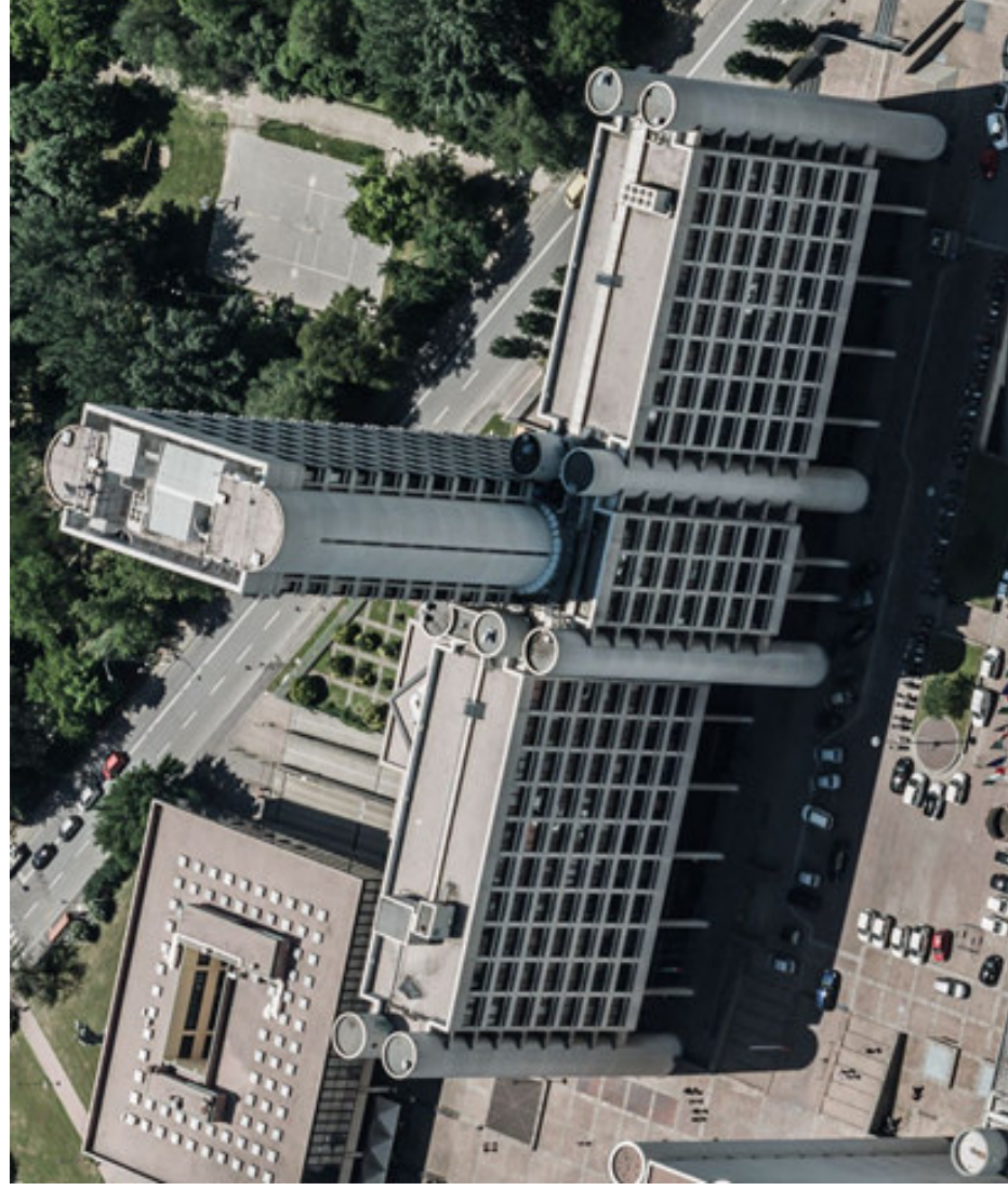
Figura 3 - Vista Nord dell'edificio oggetto di diagnosi
