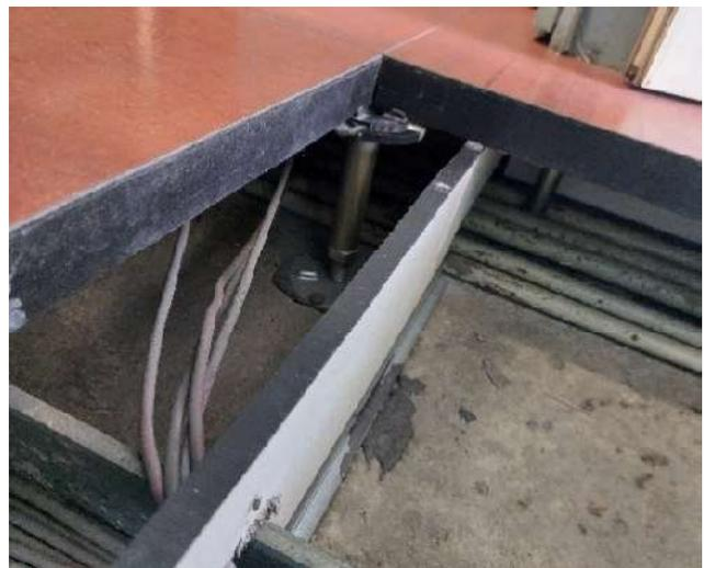
Figura 40: Dettaglio della pavimentazione in corrispondenza dell'area antistante gli ascensori con il passaggio da pavimentazione galleggiante a pavimentazione incollata (sx) e dettaglio della pavimentazione galleggiante in corrispondenza delle tramezzature (dx) con evidenza del setto presente al disotto della pavimentazione e in corrispondenza delle pareti con funzione di fonoassorbente per limitare la diffusione sonora fra locali.
