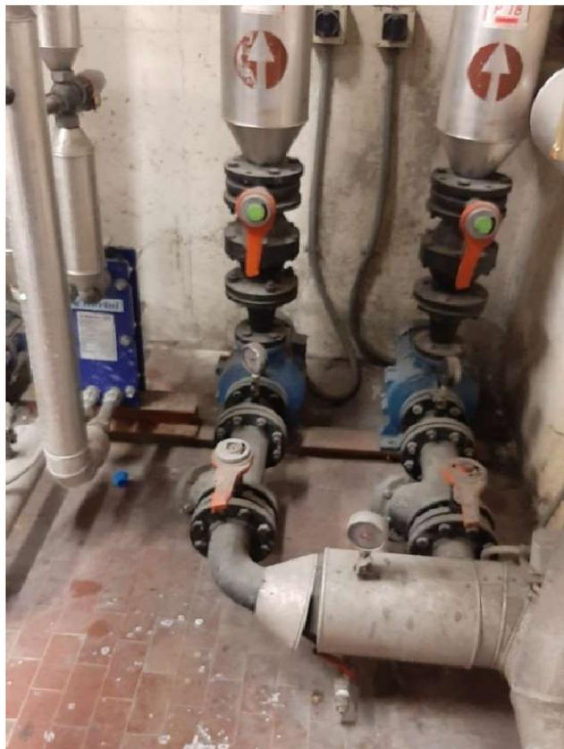
Figura 28: pompe gemellari impianto di riscaldamento
