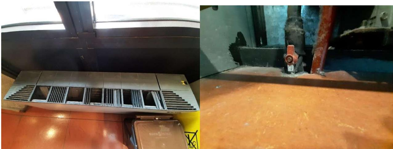
Figura 35: corpo scaldante (dettaglio tubazioni e valvole)
