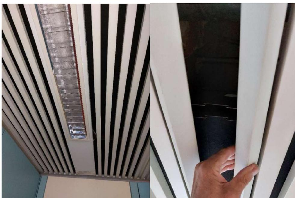
Figura 45: Controsoffitti a doghe dei locali uffici (sx); particolare del sistema di aggancio delle doghe del controsoffitto (dx).
