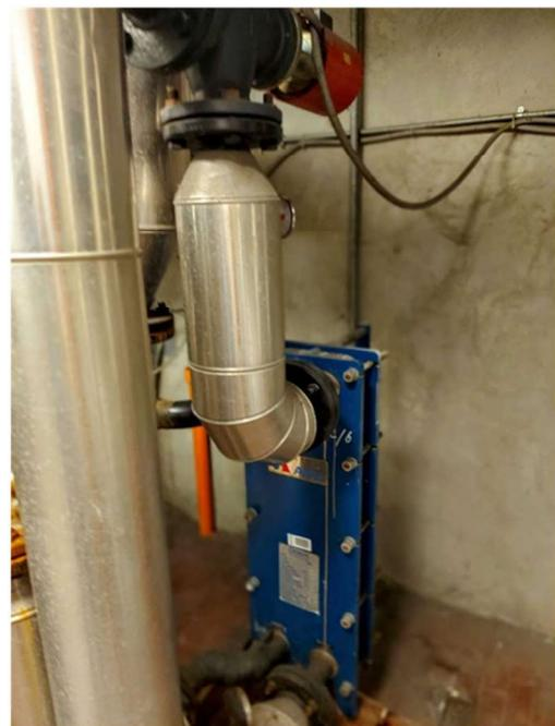
*Figura 25: Dettagli sottocentrale di scambio fluidi caldo-freddo.*
