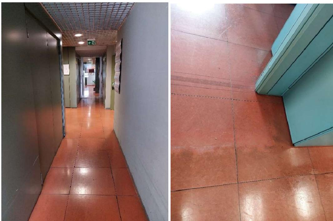
Figura 44: Vista d'insieme delle pareti mobili e controsoffitti del corridoio (sx); particolare del sistema pavimento parete mobile (dx).
