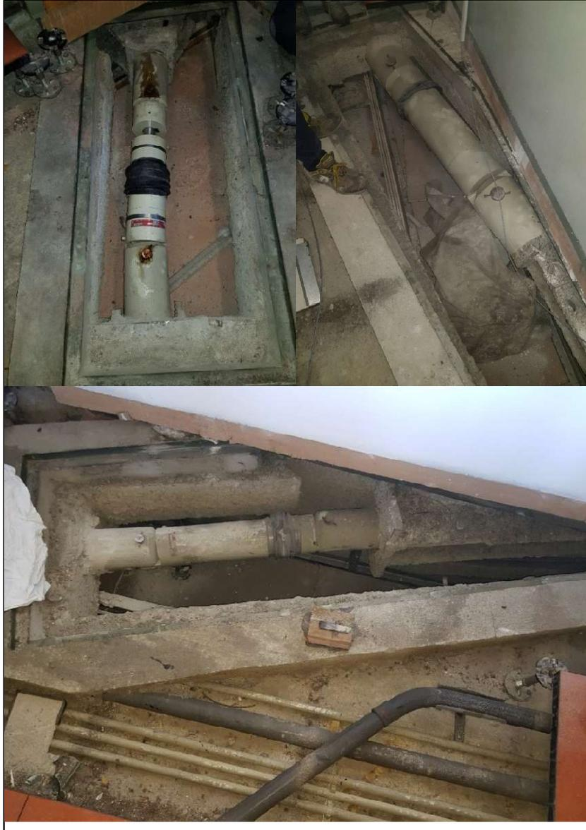
*Figura 5: Accoppiatori antisismici (shock transmitter)*
