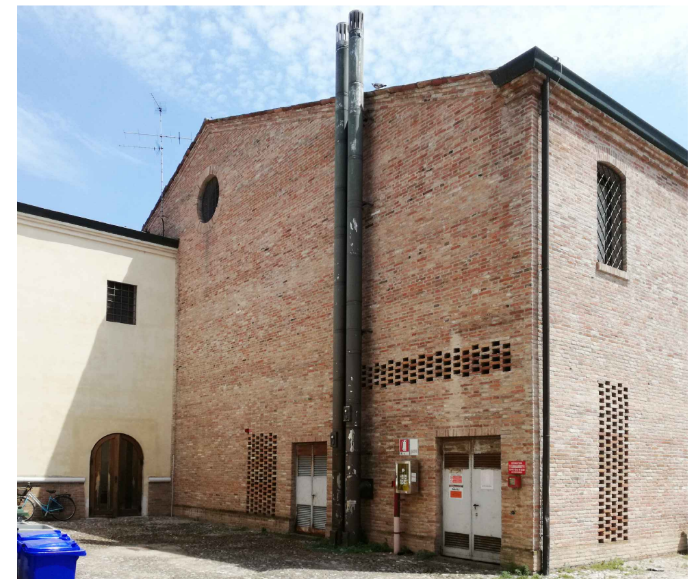
FOTO STATO DI FATTO
