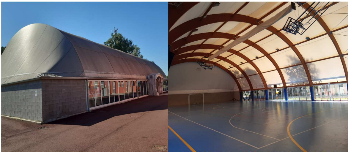
tensostruttura impianto di Via Gruppini interno tensostruttura
