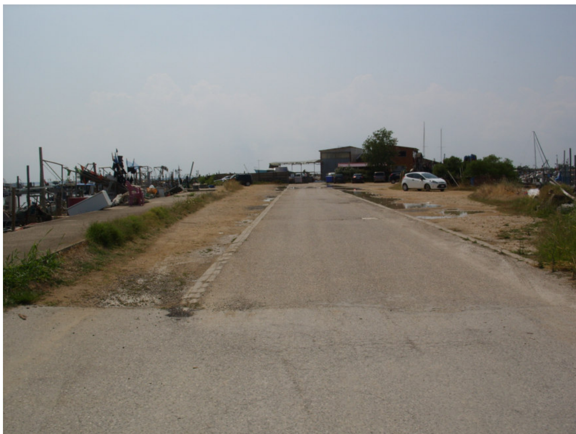
Fig. 2 - Braccio intermedio posto a sud del punto di sbarco allo stato attuale
