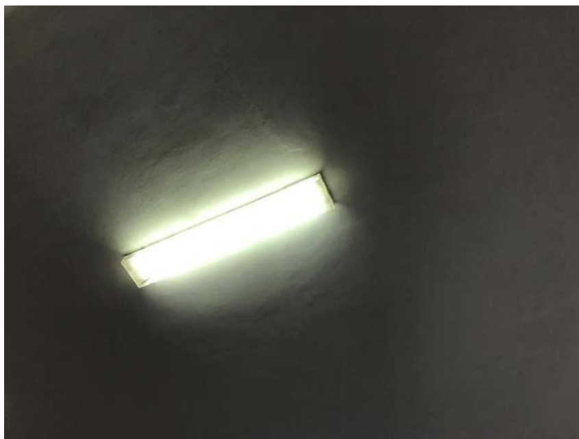
Figura 11 - Particolare corpi illuminanti
