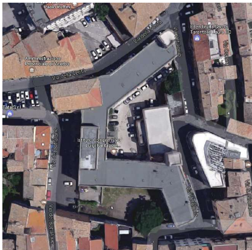
Figura 7 - Inquadramento dell'edificio oggetto di analisi
