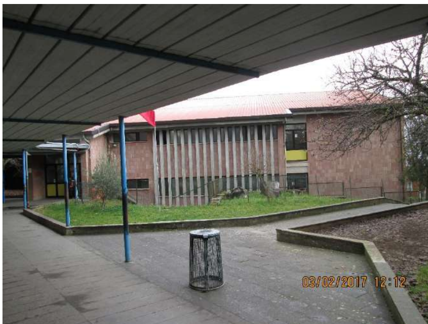
Figura 8 – Esterno della struttura
