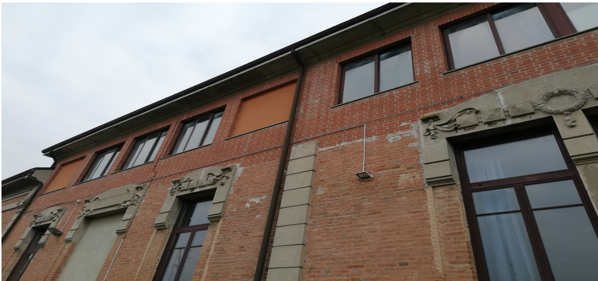
Vista esterna – dettaglio facciata – scuola
