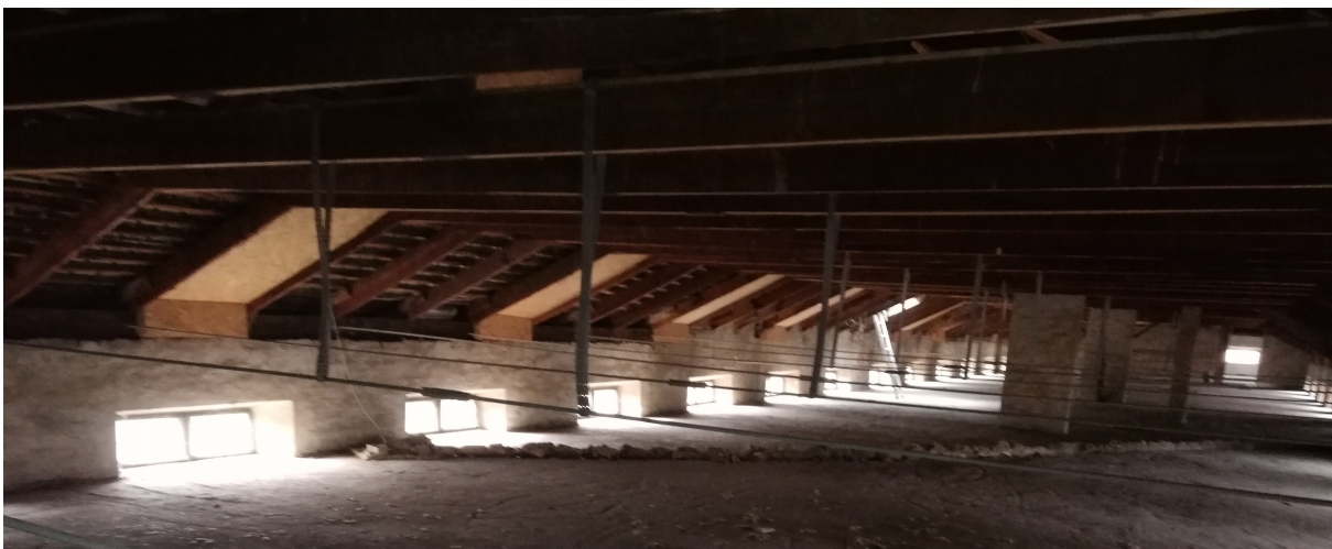
Vista interna – sottotetto - scuola
