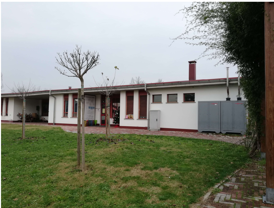
Figura 6.1 – Vista esterna – fronte principale
