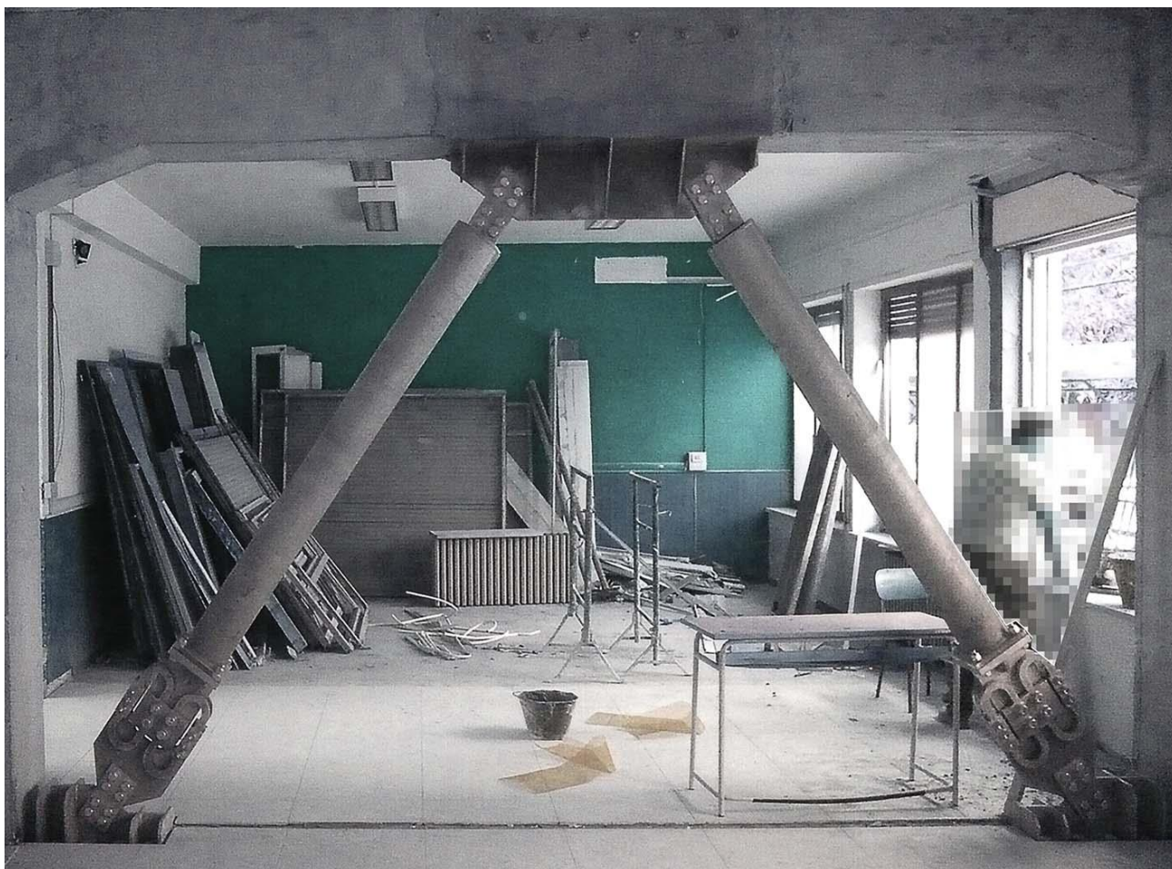
Installazione di controventi dissipativi
