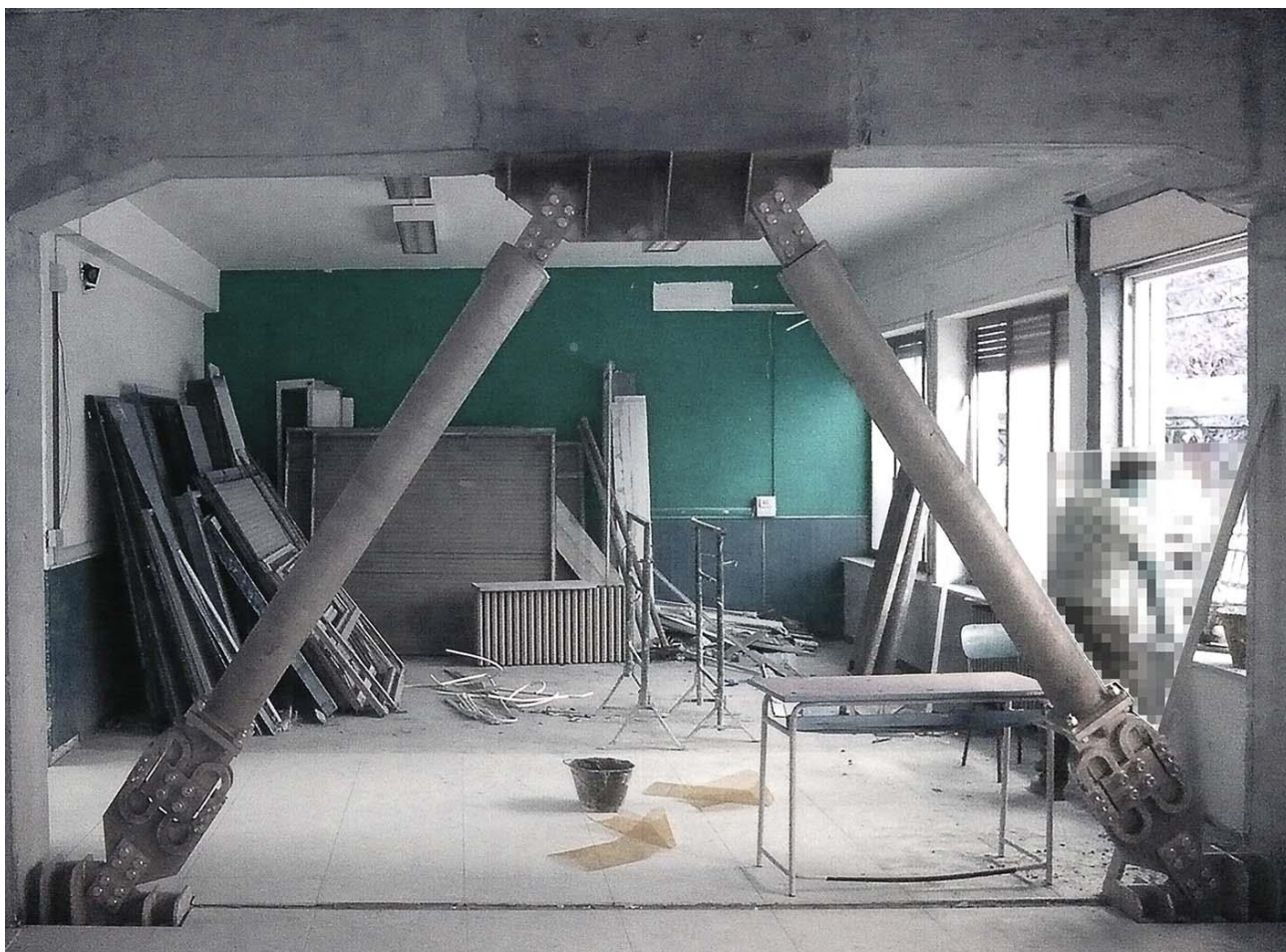
Installazione di controventi dissipativi
