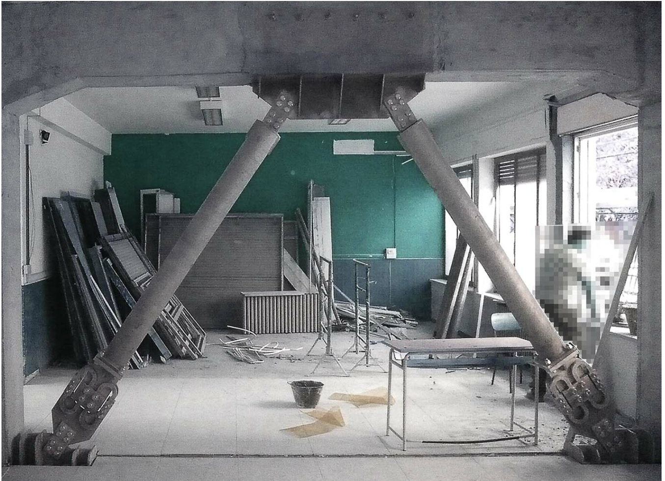
Installazione di controventi dissipativi
