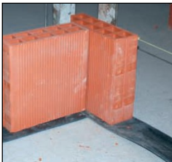
Figura 32: accorgimenti costruttivi (posa fascia tagliamuro sottoparete)
