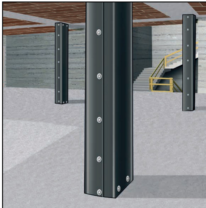
Figura 37: accorgimenti costruttivi (isolamento pilastri, fonte isolmant.com )
