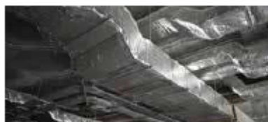
Canale metallico isolato esternamente
