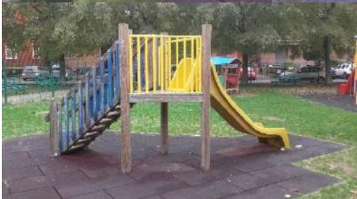
Riparazione Torretta scivolo tipo Vicky ditta Stebo installate nel campo giochi di: Via Corvi, mediante demolizione delle tavole del pavimento della piattaforma della torretta e sostituzione con tavole in legno di pino di Svezia impregnato in autoclave certificato PEFC minimo al 85% profilo 3,5 X 14,5 cm fornite in opera, per una superficie totale di 0,61 Mq. La fornitura e posa di 2 copripalo quadrati 9X9 cm La fornitura in opera di 3 copripalo rotondi diametro 14 Cm
