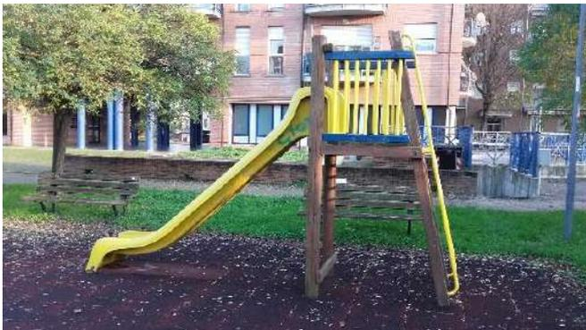
Riparazione Torretta scivolo tipo Vicky ditta Stebo installate nel campo giochi di: Via Sbolli, mediante Demolizione della scala d'accesso esistente ad esclusione dei corrimani da riutilizzare, e fornitura in opera di nuova scala in legno avente le stesse caratteristiche di quella smontata a pioli H. 150 cm, completa di viti di fissaggio con installazione dei corrimano presenti sulla scala demolita e precedentemente smontati
