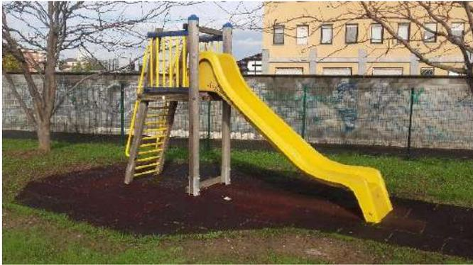
Riparazione Torretta scivolo tipo xxxxxx ditta Stebo installate nel campo giochi di: Via Don Dieci mediante Demolizione della scala d'accesso esistente ad esclusione dei corrimani da riutilizzare, e fornitura in opera di nuova scala in legno avente le stesse caratteristiche di quella smontata a pioli H. 150 cm, completa di viti di fissaggio con installazione dei corrimano presenti sulla scala demolita e precedentemente smontati
