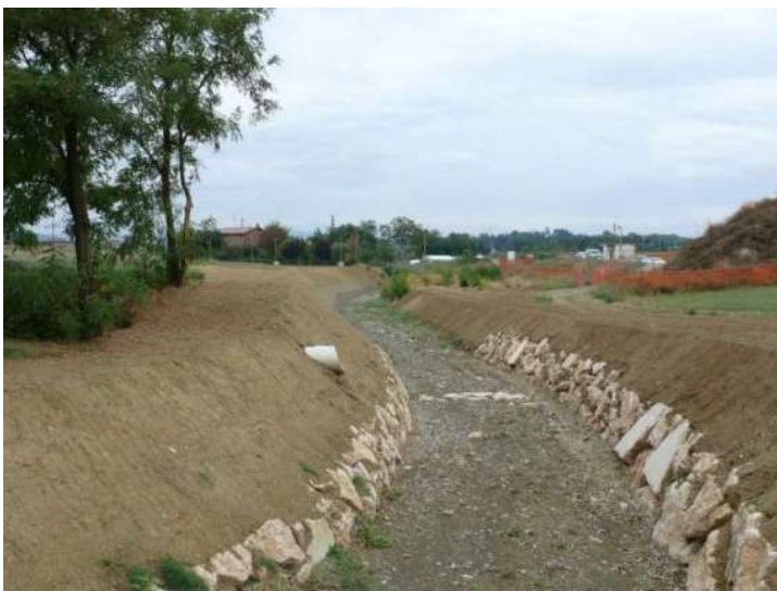
Figura 24 – Esempi fotografici di sistemazioni mediante scogliere
