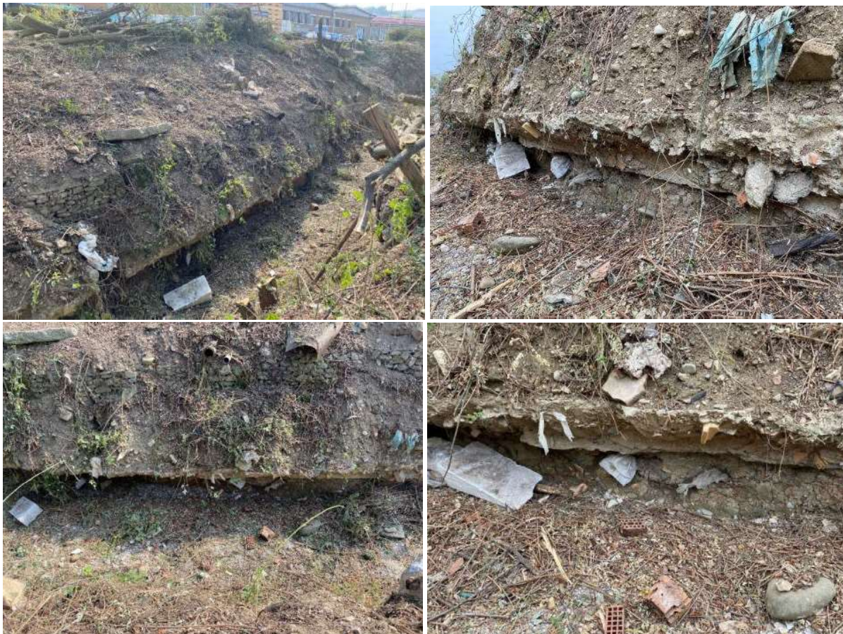
Figura 15 – Riprese fotografiche dell'erosione basale rilevata sulla sponda destra
