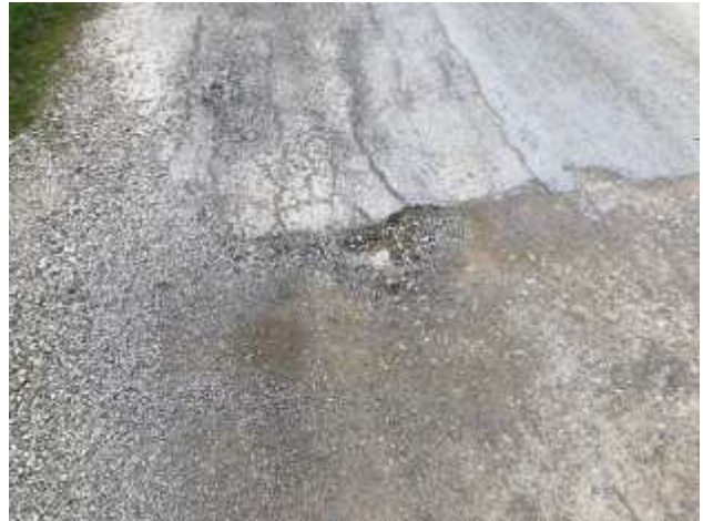
Foto 80 – Via Rondelli. Primo tratto di intervento verso il centro abitato. Scavo, posa di nuovo stabilizzato, binder e tappeto di usura.
