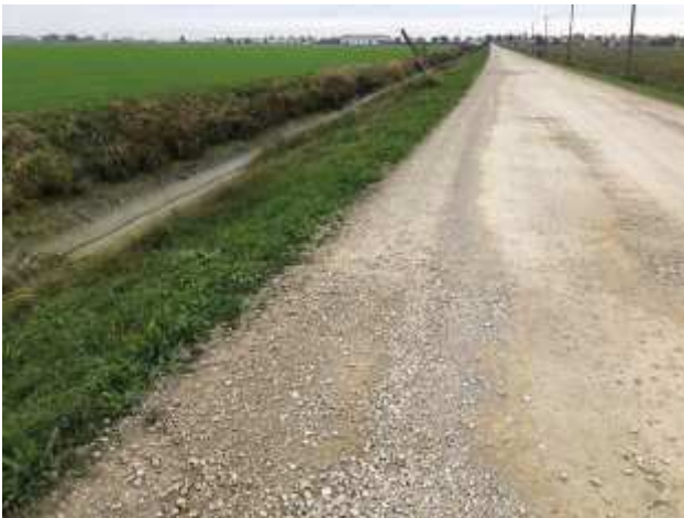
Foto 83 – Via Rondelli. Secondo tratto di intervento verso il fiume. Scavo, posa di nuovo stabilizzato, binder e tappeto di usura.
