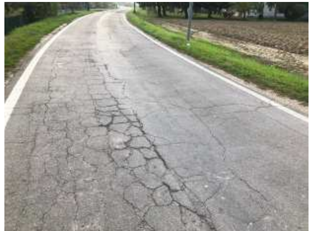
Foto 76 – Via Passetto. Fresatura manto stradale ed esecuzione di nuovo tappeto di usura in conglomerato bituminoso.
