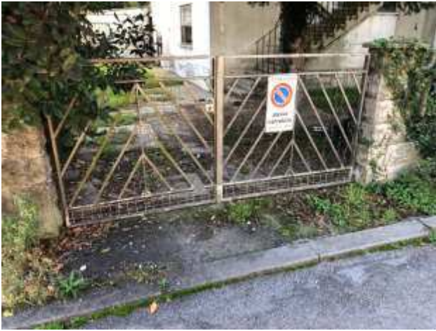
Foto 13 – Via Argelli – Sostituzione cordolo marciapiede per realizzazione di accesso carraio, scavo, realizzazione di soletta in c.a. e tappeto e manto di usura in conglomerato bituminoso
