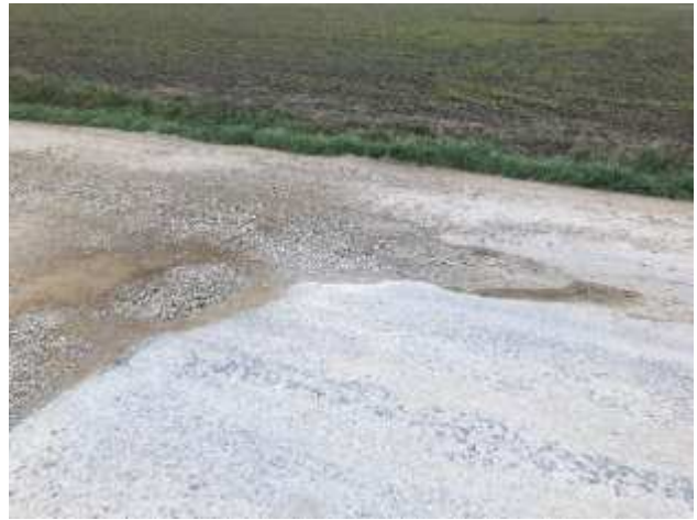
Foto 82 – Via Rondelli. Secondo tratto di intervento verso il fiume. Scavo, posa di nuovo stabilizzato, binder e tappeto di usura.
