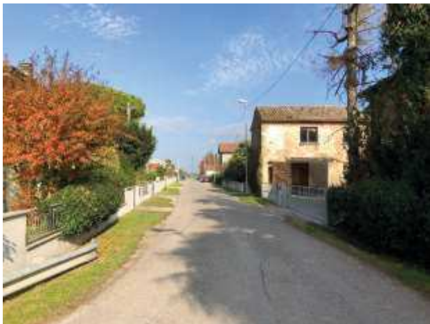
Foto 55 – Via Guerrina – Fresatura e nuovo tappeto di usura in conglomerato bituminoso.
