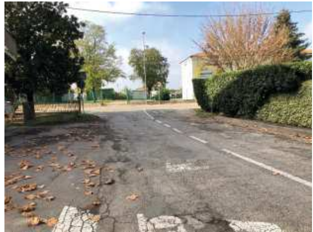
Foto 58 – Via Bassa – LONGASTRINO – Via Valletta – Fresatura manto stradale ed esecuzione di nuovo tappeto di usura in conglomerato bituminoso.
