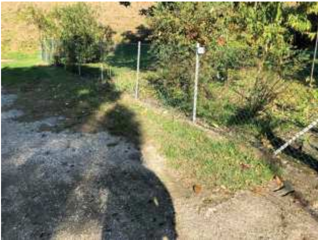
Foto 27 – Via Divisione Cremona – sostituzione maschera caditoia con nuova in ghisa carrabile, messa in quota, scavo, realizzazione di sottofondo e tappeto di usura in conglomerato bituminoso.
