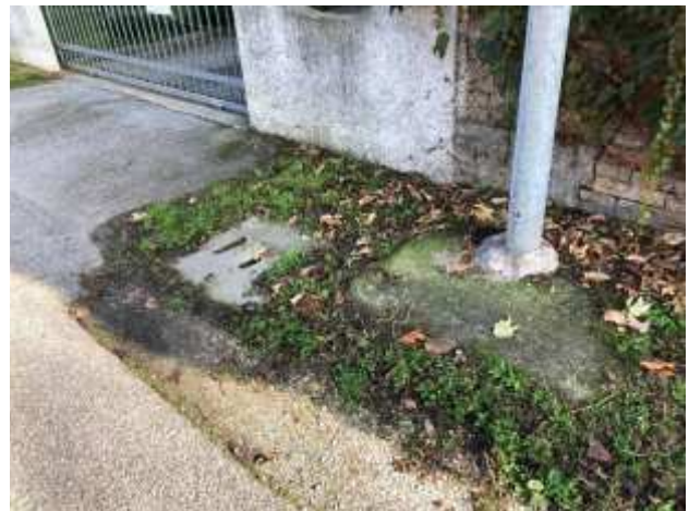
Foto 56 – Via Guerrina – Sostituzione caditoia con nuovo elemento in ghisa.
