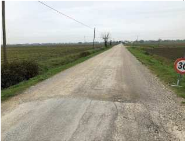
Foto 77 – Via Rondelli. Primo tratto di intervento verso il centro abitato. Scavo, posa di nuovo stabilizzato, binder e tappeto di usura.
