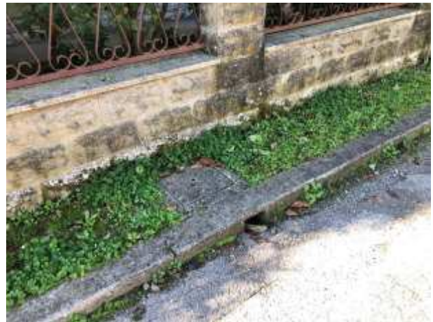
Foto 20 – Via Argelli - Sostituzione maschera pozzetto con nuova in ghisa, scavo marciapiede, realizzazione di soletta in c.a. e tappeto e manto di usura in conglomerato bituminoso
