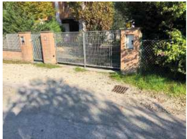
Foto 36 – Via Divisione Cremona – Scavo banchine, sostituzione caditoie con nuove in ghisa carrabile e loro messa in quota, nuovo sottofondo, formazione pendenze, fresatura asfalto esistente e tappeto di usura in conglomerato bituminoso.
