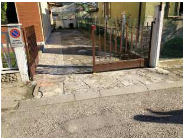
Foto 11 – Via Argelli – scavo, realizzazione soletta in c.a. sostituzione maschera pozzetto con nuova in ghisa carrabile e tappeto di usura in conglomerato bituminoso
