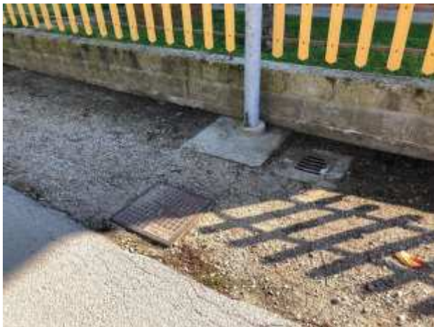
Foto 35 – Via Divisione Cremona – Scavo banchine, spostamento pozzetto e sostituzione caditoie con nuove in ghisa carrabile e loro messa in quota, nuovo sottofondo, formazione pendenze, fresatura asfalto esistente e tappeto di usura in conglomerato bituminoso.
