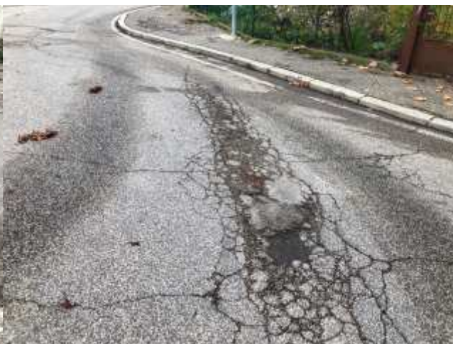
Foto 46 – Via Mameli, rotonda con Via XXVIII Brigata Garibaldi – Fresatura asfalto, tappeto di usura in conglomerato bituminoso.
