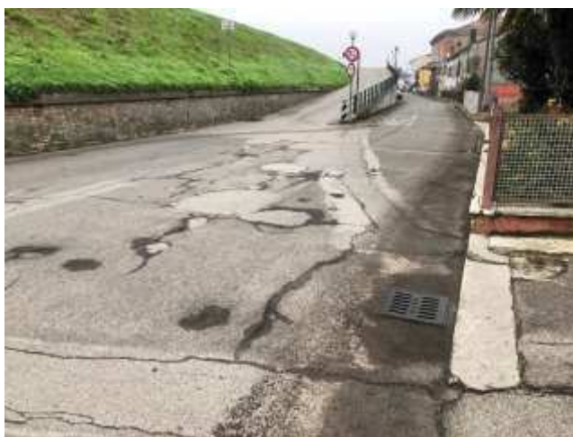
Foto 47 – Via Mameli – Fresatura asfalto, tappeto di usura in conglomerato bituminoso.
