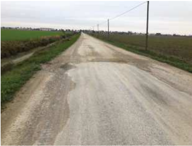
Foto 81 – Via Rondelli. Secondo tratto di intervento verso il fiume. Scavo, posa di nuovo stabilizzato, binder e tappeto di usura.
