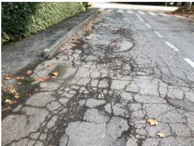
Foto 59 – Via Bassa – LONGASTRINO – Via Valletta – Abbassamento cordolo di testa marciapiede. Fresatura manto stradale ed esecuzione di nuovo tappeto di usura in conglomerato bituminoso.
