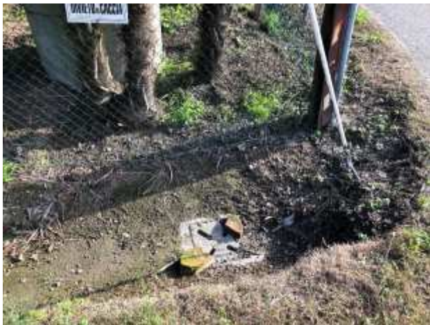
Foto 59 – Via Guerrina – Sostituzione caditoia con nuovo elemento in ghisa.
