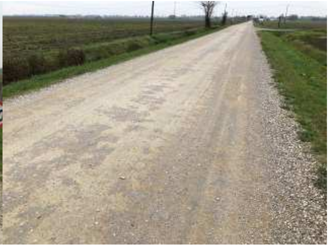
Foto 78 – Via Rondelli. Primo tratto di intervento verso il centro abitato. Scavo, posa di nuovo stabilizzato, binder e tappeto di usura.
