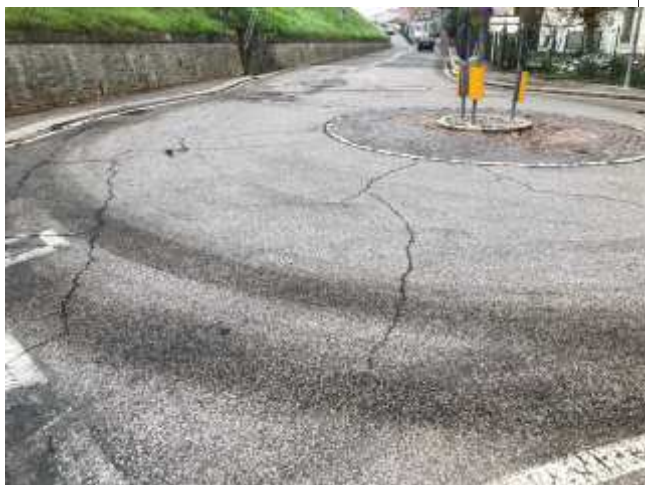
Foto 45 – Via Mameli, rotonda con Via XXVIII Brigata Garibaldi – Fresatura asfalto, tappeto di usura in conglomerato bituminoso.
