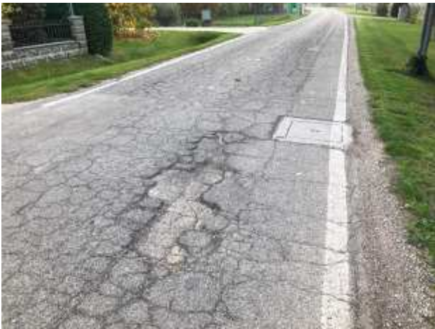
Foto 75 – Via Passetto. Sostituzione maschera e caditoia con nuove in ghisa. Fresatura manto stradale ed esecuzione di nuovo tappeto di usura in conglomerato bituminoso.
