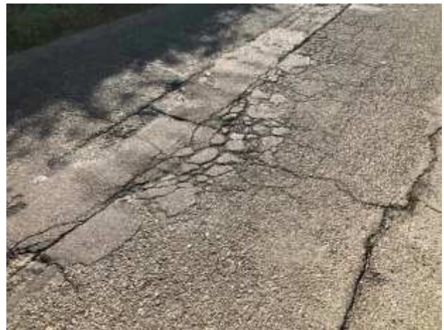
Foto 44 – Via Mameli – Fresatura asfalto, tappeto di usura in conglomerato bituminoso.
