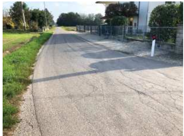
Foto 60 – Via Guerrina - Fresatura e nuovo tappeto di usura in conglomerato bituminoso.
