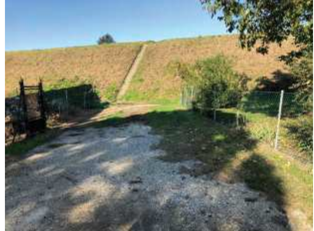
Foto 26 – Via Divisione Cremona – Scavo, completamento di sottofondo, inserimento cordolo da 8 cm a chiusura della strada tenendo come riferimento lo spigolo della proprietà del demanio (fabbricato lato sx strada), eventuale fresatura, tappeto di usura in conglomerato bituminoso.
