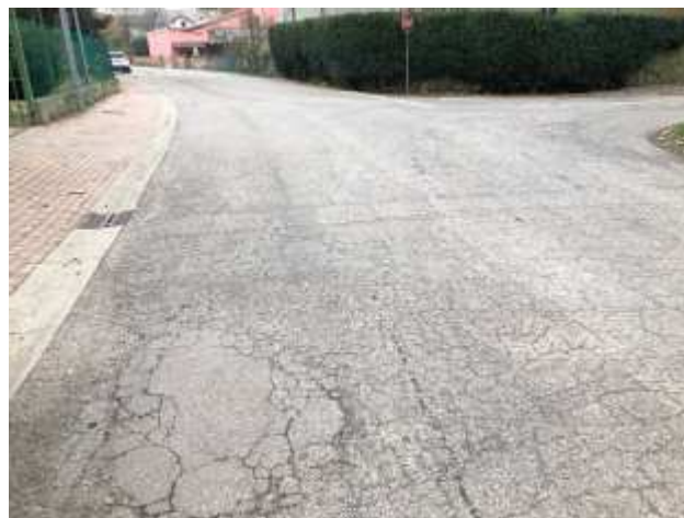
Foto 68 – Via Bassa – LONGASTRINO – Fresatura manto stradale ed esecuzione di nuovo tappeto di usura in conglomerato bituminoso. Rifacimento segnaletica orizzontale.
