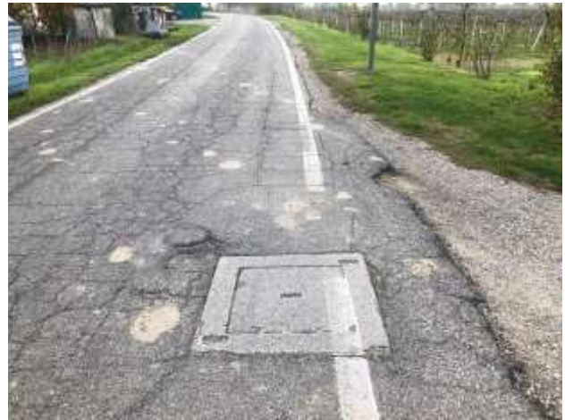
Foto 74 – Via Passetto. Sostituzione maschera e caditoia con nuove in ghisa. Fresatura manto stradale ed esecuzione di nuovo tappeto di usura in conglomerato bituminoso.
