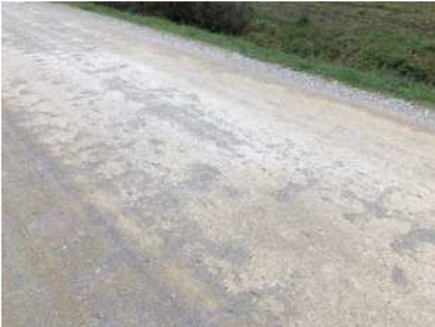
Foto 79 – Via Rondelli. Primo tratto di intervento verso il centro abitato. Scavo, posa di nuovo stabilizzato, binder e tappeto di usura.
