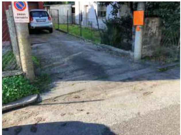
Foto 12 – Via Argelli – scavo, realizzazione soletta in c.a. e tappeto di usura in conglomerato bituminoso
