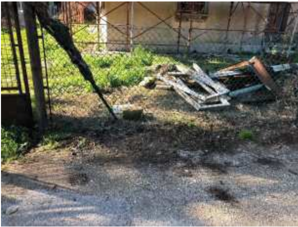
Foto 25 – Via Divisione Cremona – Inserimento di cordolo da 8 cm a sx lato recinzione in rete metallica proprietà demanio, scavo, completamento di sottofondo, eventuale fresatura, tappeto di usura in conglomerato bituminoso.
