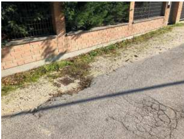
Foto 23 – Via Divisione Cremona – sostituzione caditoia con nuova a norma, messa in quota della stessa, scavo, realizzazione di sottofondo e tappeto di usura in conglomerato bituminoso.
