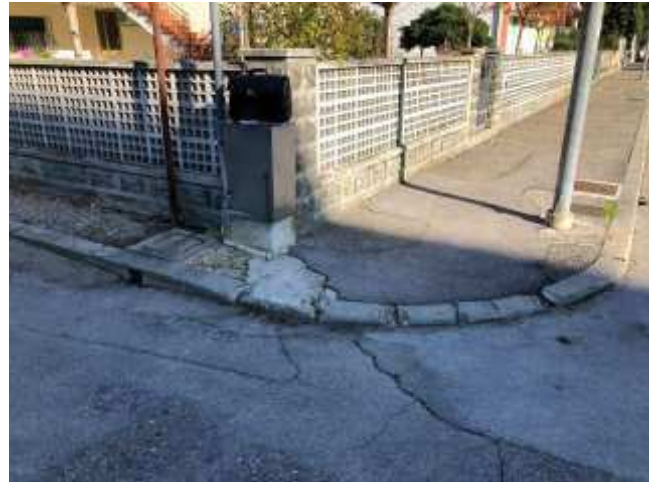
Foto 2 – Via Argelli (incrocio con C.so Garibaldi – lato dx) – sostituzione cordoli
