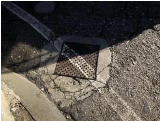
Foto 43 – Via Mameli – Sistemazione di maschera del pozzetto, fresatura asfalto, tappeto di usura in conglomerato bituminoso.
