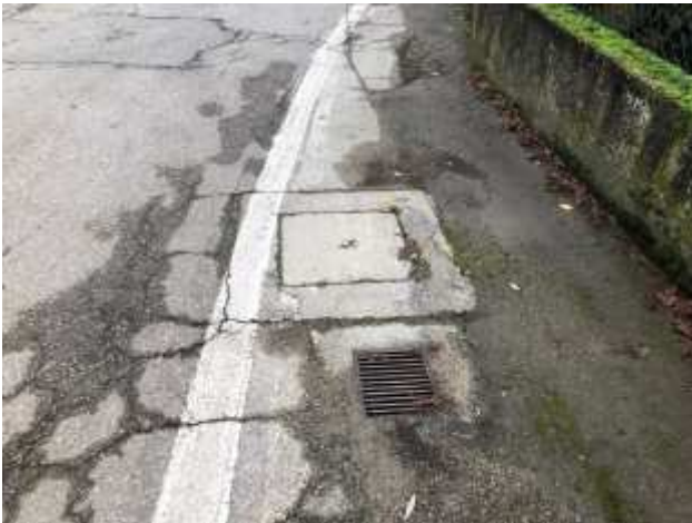
Foto 73 – Via Passetto. Sostituzione maschera e caditoia con nuove in ghisa. Fresatura manto stradale ed esecuzione di nuovo tappeto di usura in conglomerato bituminoso.
