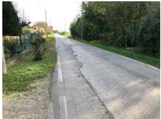
Foto 52 – Via Guerrina – Fresatura e nuovo tappeto di usura in conglomerato bituminoso.
