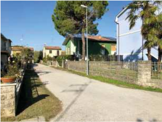
Foto 33 – Via Divisione Cremona – Scavo banchine, sostituzione caditoie con nuove in ghisa carrabile e loro messa in quota, nuovo sottofondo, formazione pendenze, fresatura asfalto esistente e tappeto di usura in conglomerato bituminoso.
