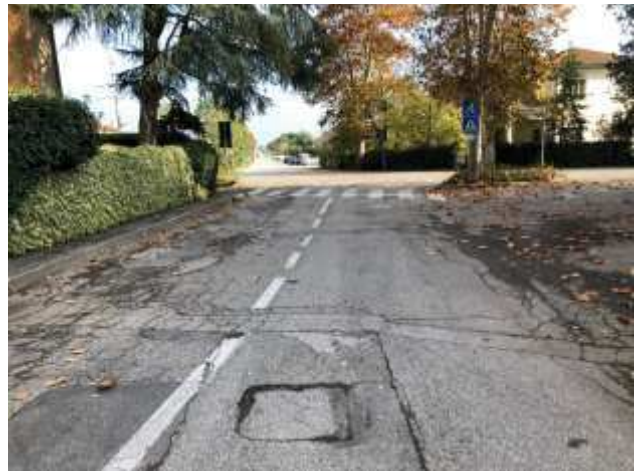
Foto 60 – Via Bassa – LONGASTRINO – Via Valletta – Fresatura manto stradale ed esecuzione di nuovo tappeto di usura in conglomerato bituminoso.
