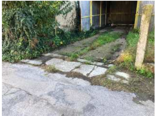
Foto 14 – Via Argelli - Sostituzione cordolo marciapiede per realizzazione di accesso carraio, scavo, realizzazione di soletta in c.a. e tappeto e manto di usura in conglomerato bituminoso
