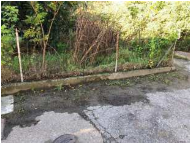
Foto 15 – Via Argelli – Scavo, realizzazione di sottofondo e tappeto di usura in conglomerato bituminoso
