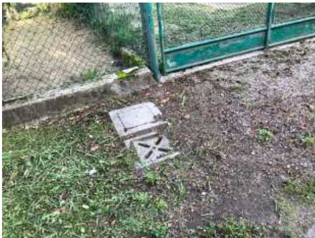
Foto 51 – Via Guerrina – Sostituzione caditoia e maschera pozzetto con nuovi elementi in ghisa.
