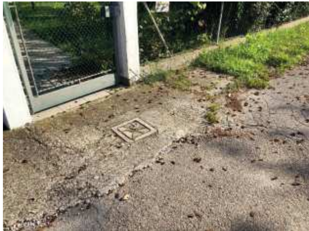
Foto 28 – Via Divisione Cremona – Sostituzione maschera pozzetto con nuova in ghisa, scavo, realizzazione di sottofondo e tappeto di usura in conglomerato bituminoso.
