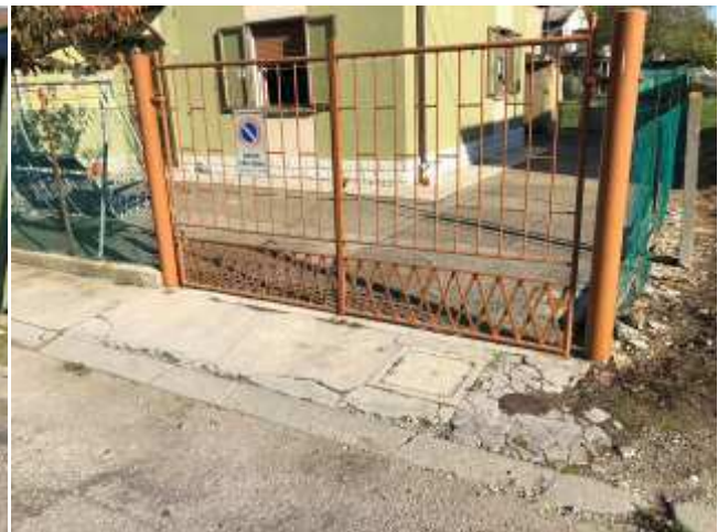
Foto 8 – Via Argelli – scavo, realizzazione soletta in c.a., tappeto di usura in conglomerato bituminoso
