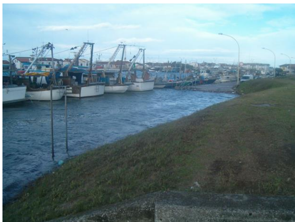
Attacco con parte Nord della banchina –2008
