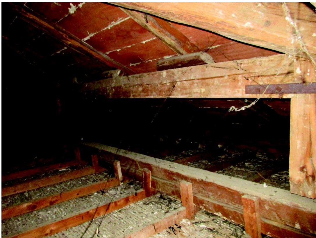
FOTO 32: incavallatura ortogonale alla facciata (appoggio lontano)
