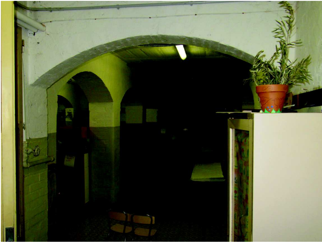
FOTO 10: vista interna al piano seminterrato
