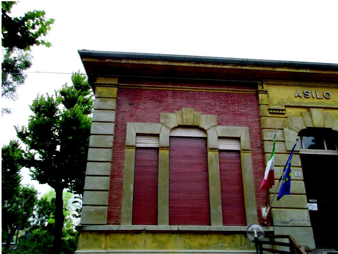
FOTO 22: parte del prospetto sud
