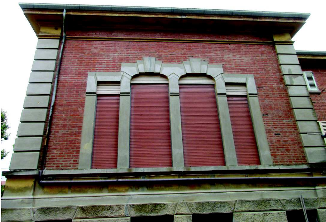
FOTO 14: parte del prospetto est
