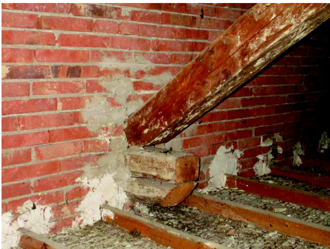
FOTO 35: base della capriata a sostegno del colmo
