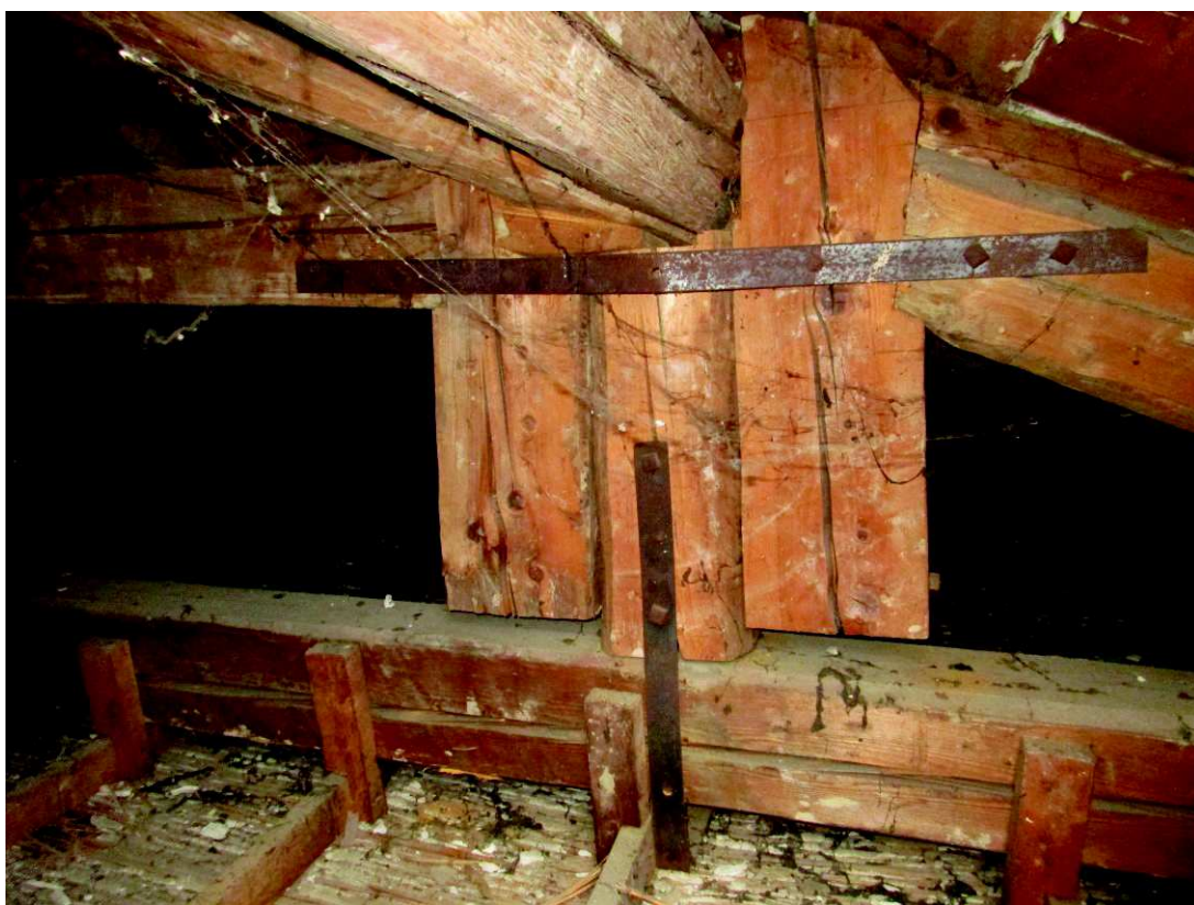
FOTO 31: incavallatura ortogonale alla facciata (zona centrale)
