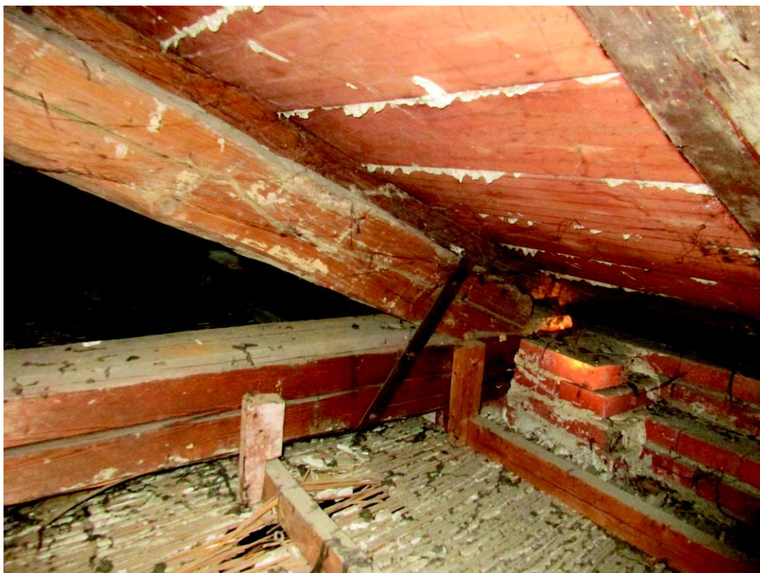
FOTO 30: incavallatura ortogonale alla facciata (appoggio vicino)
