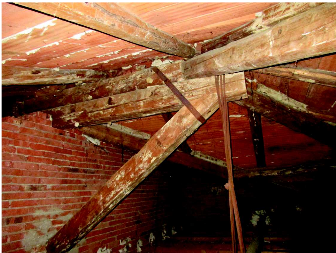
FOTO 34: capriata a sostegno del colmo
