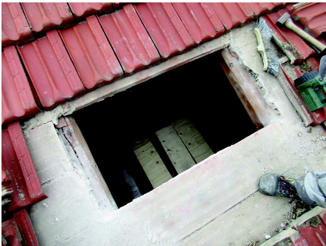
FOTO 29: foro ottenuto asportando di un tavellone
