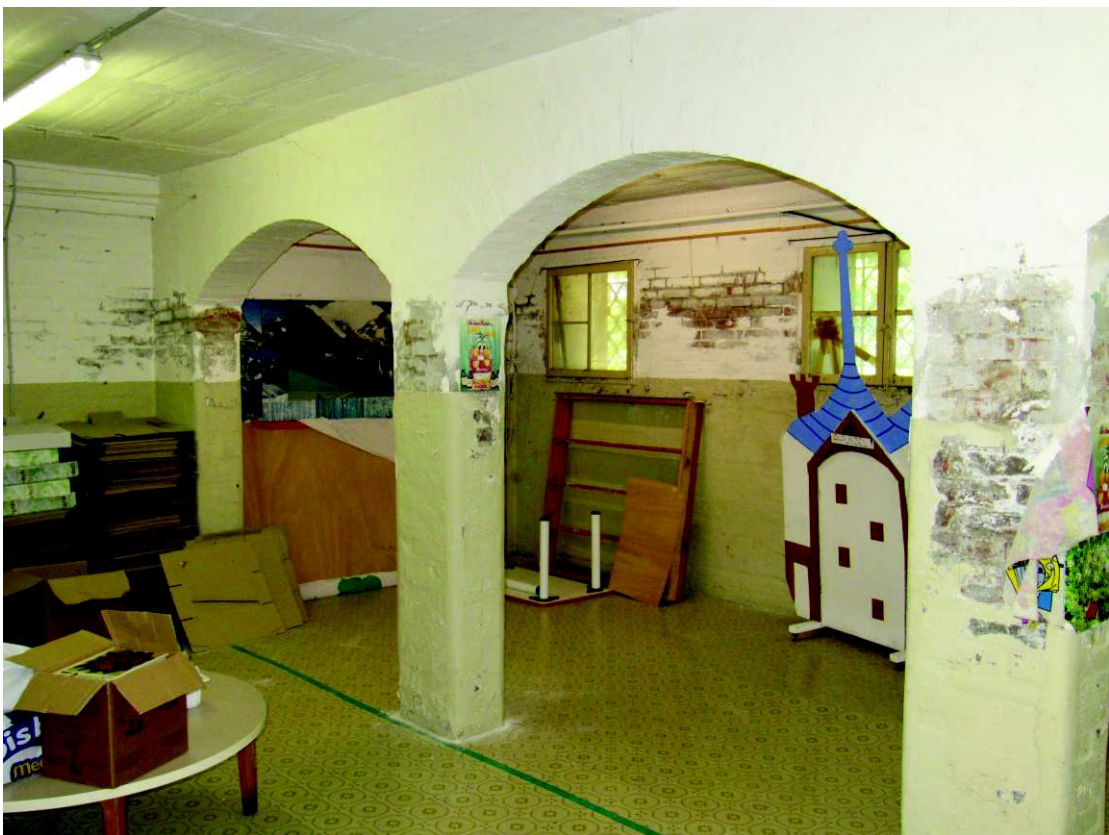
FOTO 11: vista interna al piano seminterrato
