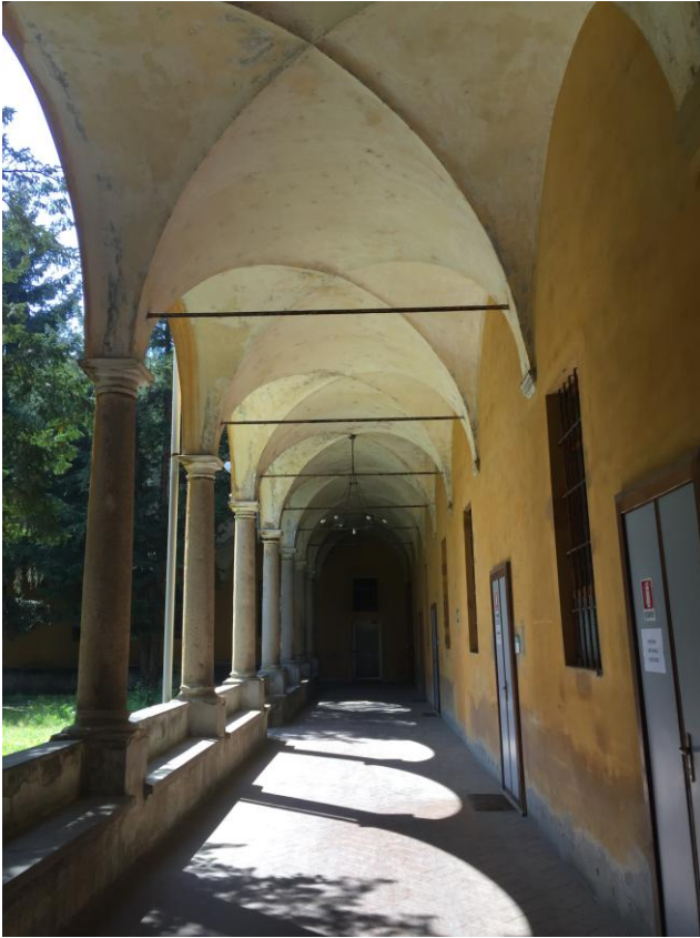
Figura 9. Particolare del colonnato
