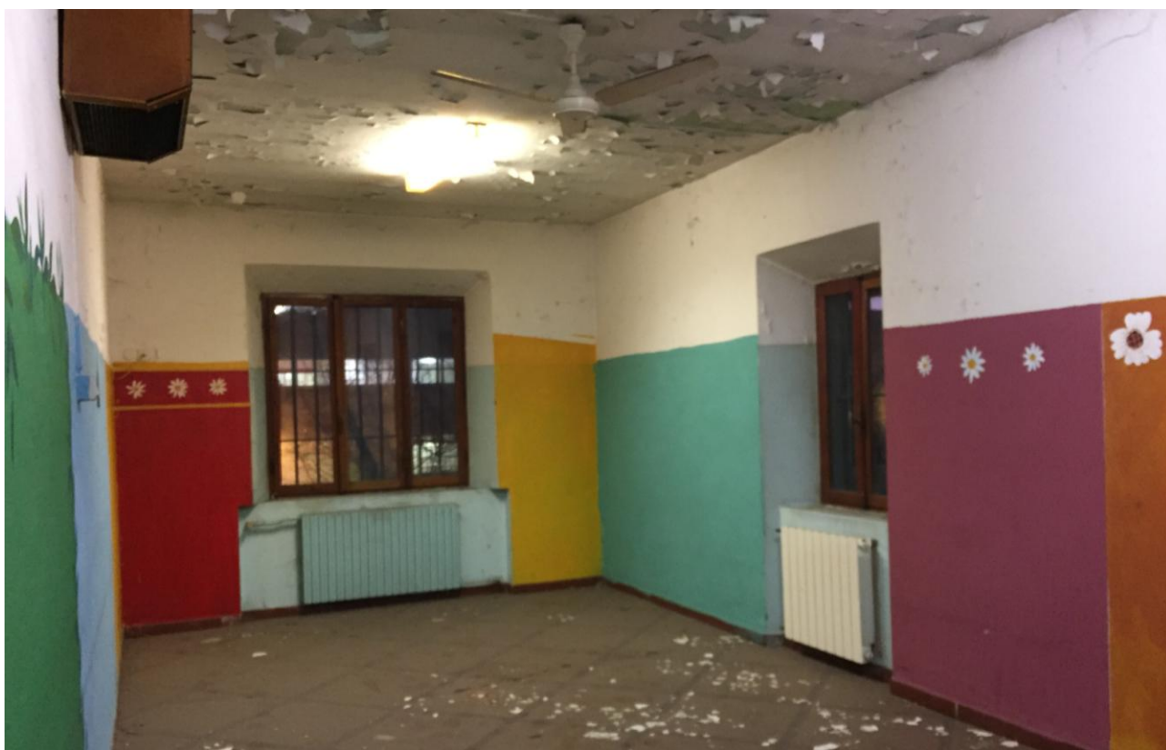
Figura 14. Particolare del locale con soffitto piano
