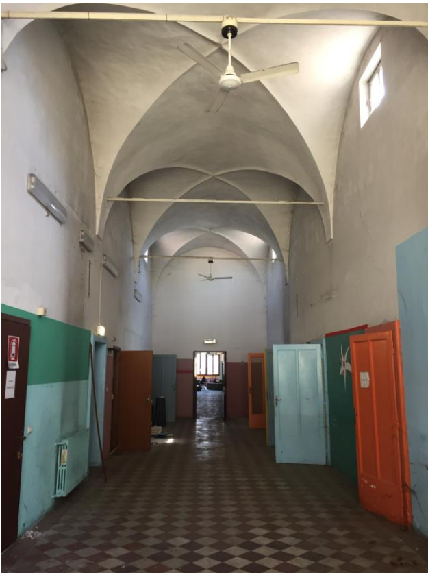
Figura 11. Vista del corridoio centrale
