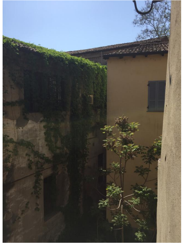
Figura 10. Vista del cortile nord
