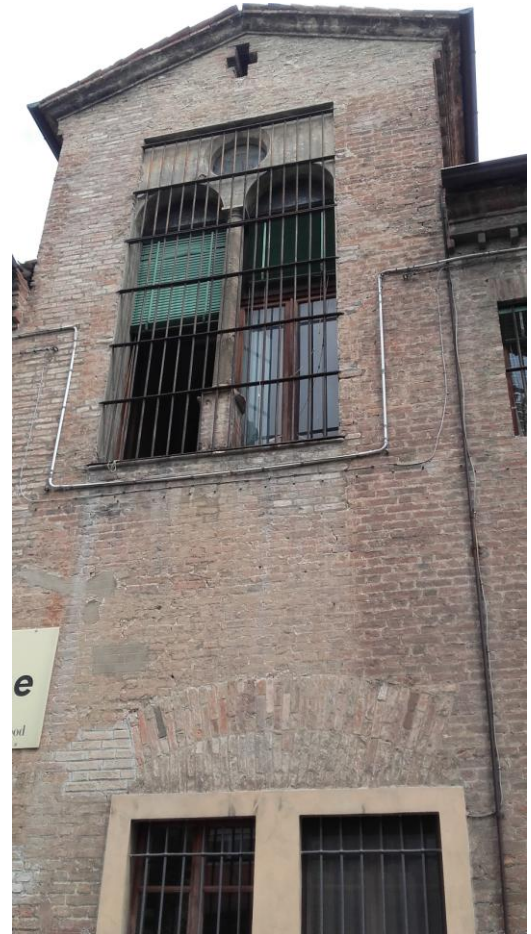
Figura 7. Particolare della bifora
